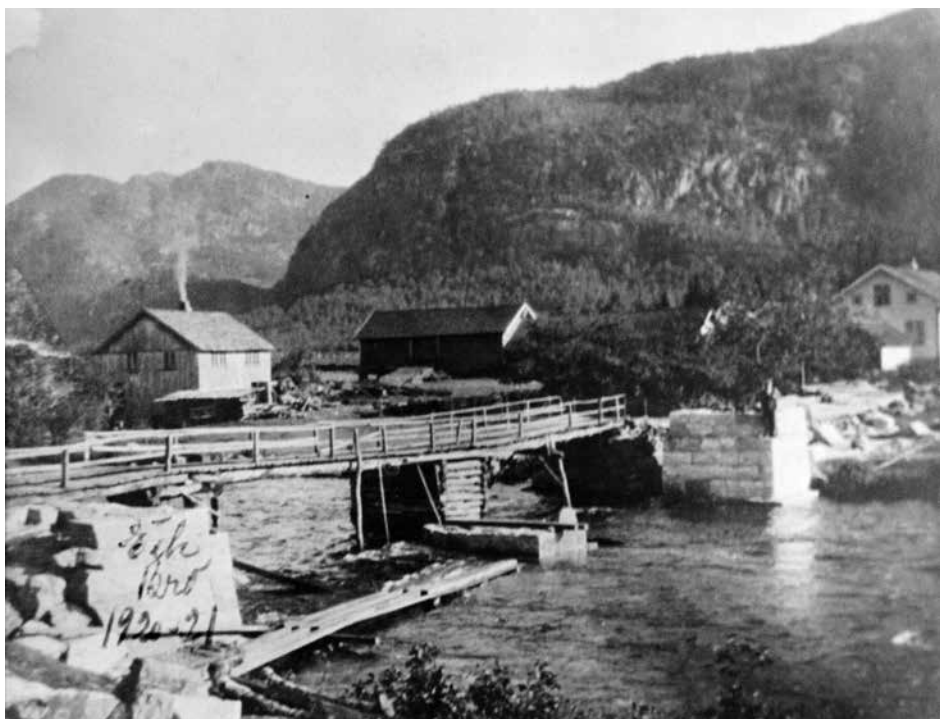
Det gamle meieriet er huset til venstre. Foran huset ligger det materialer som skal brukes til den første treskofabrikken. Vi ser også at den gamle brua over elva er i ferd med å bli erstattet av ei ny. Foto: ukjent, ca. 1920/21.
