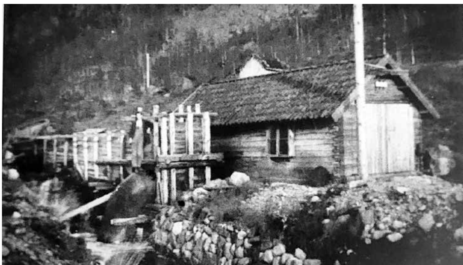
Verket i Teian ble bygget på tomte til Surdal Rokkefabrikk etter at den ble nedlagt. Mannen på bilde er Theodor Mikkelsen. Foto Geirulf Mikkelsen. Utlånt av Magnar Handeland.
