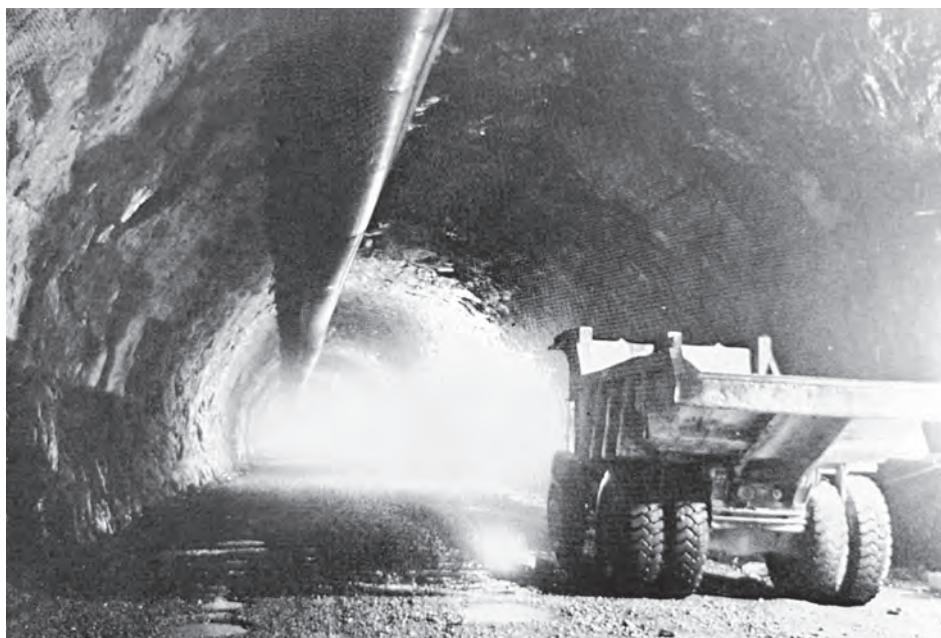
Kraftverkstunnel i Hallingdal 1963. Foto fra anleggsboka/Sigve Rusdal.
