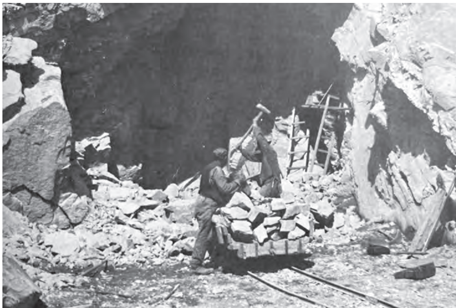
Opplasting av første tunnelsalve. Bilder fra anleggsboka Fra feisel til fullprofil, om fjellsprengere i samfunnets tjeneste, av Frode Færøyvik. Utlånt av Sigve Rusdal.
