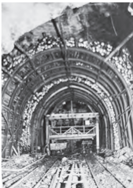
Sikring mot nedfall av stein. Foto fra anleggsboka/Sigve Rusdal.
